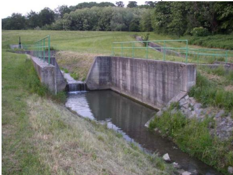
Slika 2.3: Hidrotehnička stepenica
