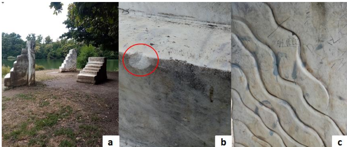
Slika 3.1.13.1. Oštećenja zatečena na Stepenicama: a) prikaz stepenica; b) prsnuće; c) prljanje i grafiti.
