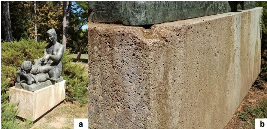
Slika 3.1.14.1 Oštećenja zatečena na kipu Majka s djetetom: a) prikaz kipa; b) mrljanje malahitom.
