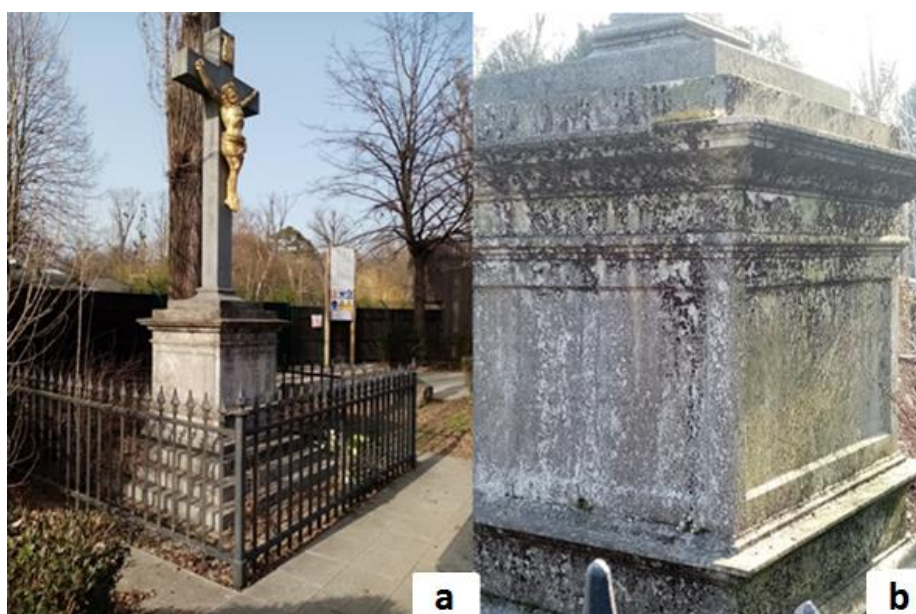
Slika 3.1.15.1. Oštećenja zatečena na Raspelu: a) prikaz Raspela; b) prljanje, crna kora, ljuštenje prljavštine i biološka kolonizacija algi, mahovine, lišajeva.
