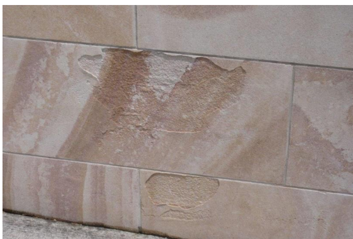
Slika 2.2.8. Odvajanje – ljuštenje
