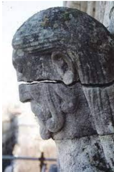
Slika 2.2.1. Horizontalna fraktura izvor: Vergès-Belmin, 2008.
