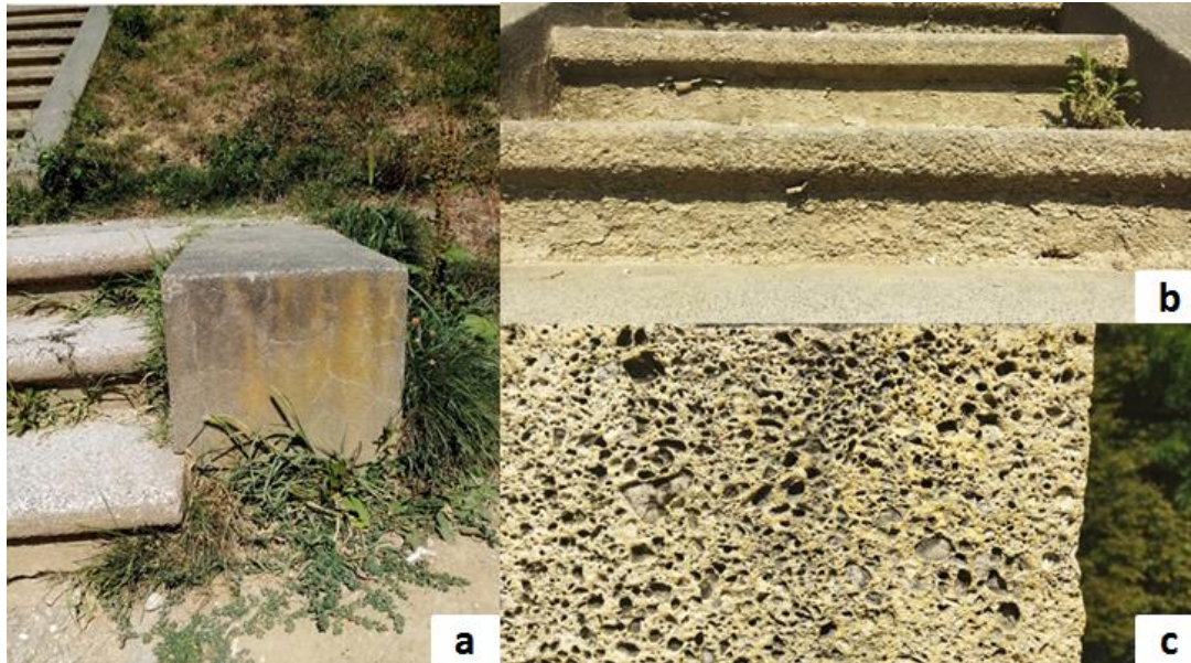
Slika 3.1.6.2. Sokolska Mogila: a) biološka kolonizacija algama i biljem; b) presvlake i ljuštenje, prljavštine i algi; c) struktura stijene.
