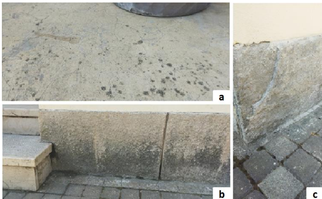
Slika 3.1.2.3. Oštećenja na podnožju vidikovca: a) pukotinska mreža, lišajevi; b) lišajevi i mahovina; c) delaminacija i mahovina.
