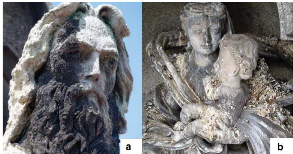
Slika 2.2.17. Tipovi oštećenja promjene boja i taloženja
