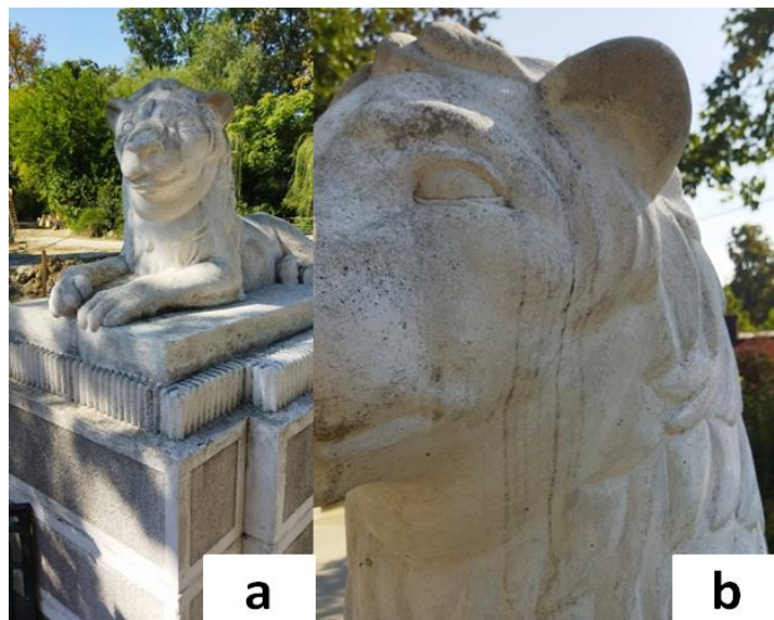
Slika 3.1.7.1 Oštećenja kipova lavova: a) prikaz jedne od skulptura; b) tragovi prljanja.
