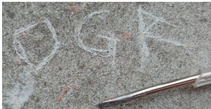
Slika 2.2.12. Oblik nastao gubitkom materijala - oštećenje nastalo mehaničkim utjecajem
