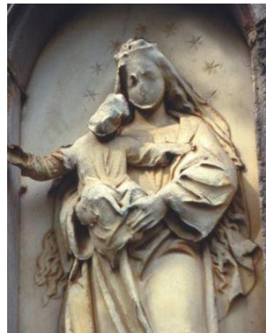
Slika 2.2.6. Dezintegracija - šećerasto granularno raspadanje arhitektonskog kamenja
