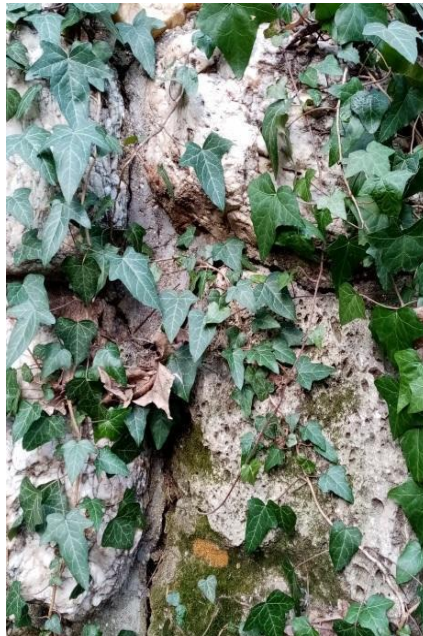
Slika 2.2.27. Biološka kolonizacija - vegetacijski obraštaj
