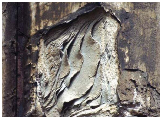
Slika 2.2.5. Odvajanje – raslojavanje izvor: Vergès-Belmin, 2008.
