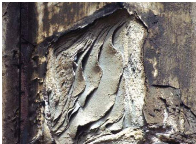
Slika 2.2.5. Odvajanje – raslojavanje izvor: Vergès-Belmin, 2008.
