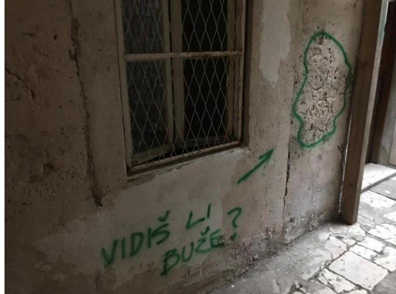
Slika 2.2.20. Tip oštećenja promjene boje- grafit na fasadi objekta i kamo opločenje koje je zbog izlizanosti postalo sjajno
