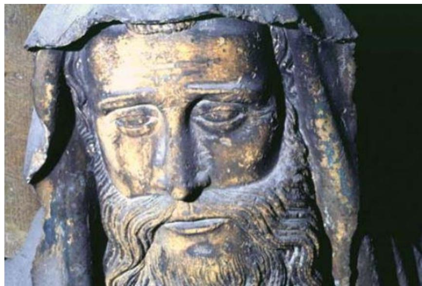
Slika 2.2.21. Tip oštećenja taloženjem - prljanje kipa (prašina u udubinama) i patinu
