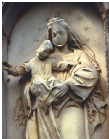
Slika 2.2.6. Dezintegracija - šećerasto granularno raspadanje arhitektonskog kamena
