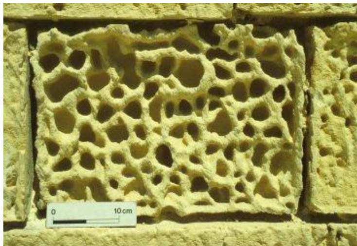
Slika 2.2.10. Oblik nastalo gubitkom materijala - pojava alveolizacije izvor: Fitzner i Heinrichs 2004.
