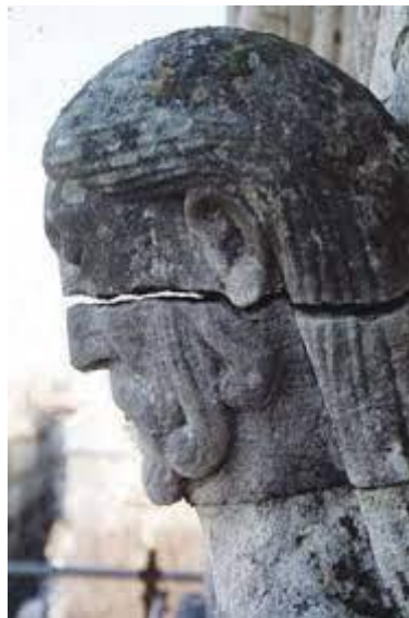
Slika 2.2.1. Horizontalna fraktura izvor: Vergès-Belmin, 2008.
