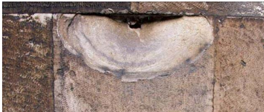
Slika 2.2.4. Odvajanje – prsnuče arhitektonskog kamena izvor: Vergès-Belmin, 2008.
