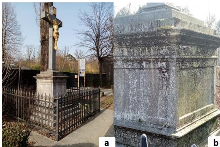
Slika 3.1.15.1. Oštećenja zatečena na Raspelu: a) prikaz Raspela; b) prljanje, crna kora, ljuštenje prljavštine i biološka kolonizacija algi, mahovine, lišajeva.
