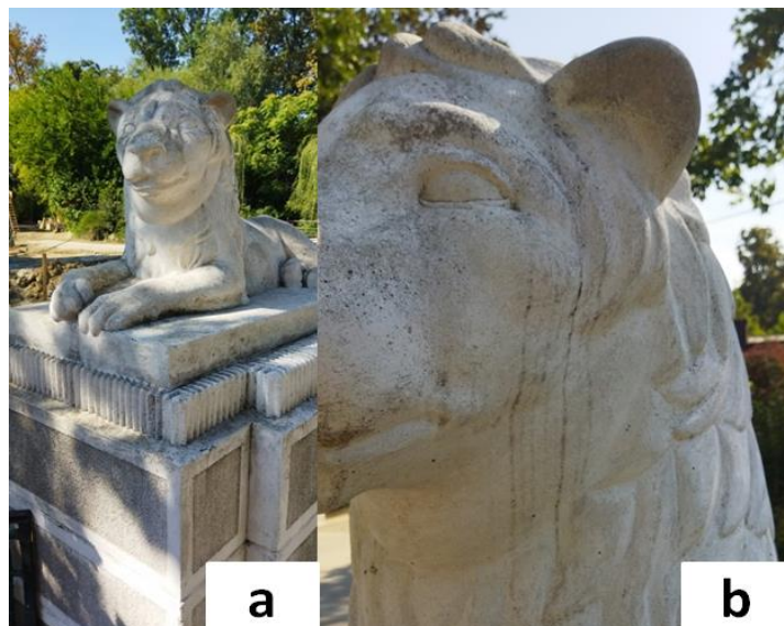
Slika 3.1.7.1 Oštećenja kipova lavova: a) prikaz jedne od skulptura; b) tragovi prljanja.
