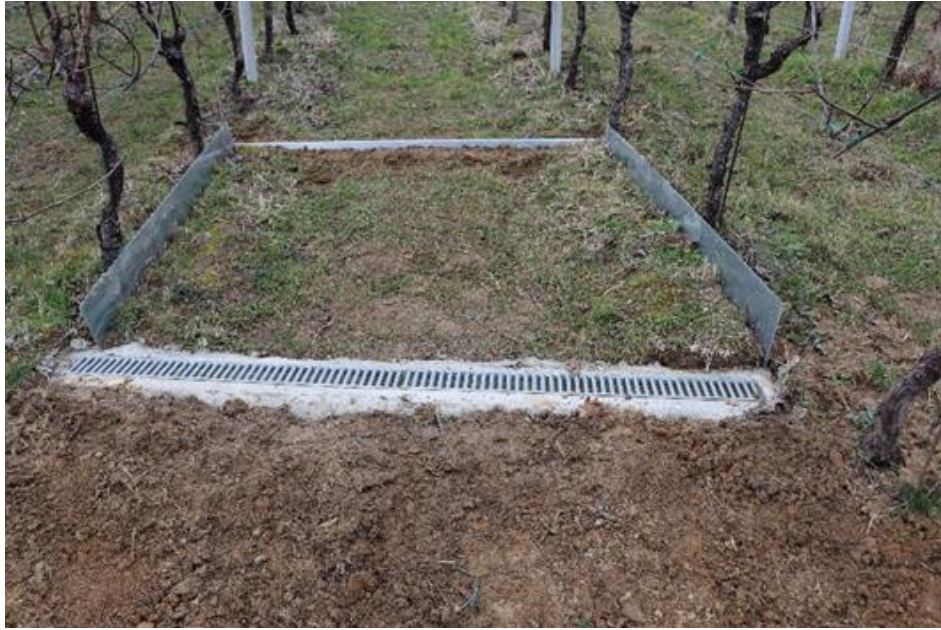
Slika 3.2.4. Sustav za površinsko otjecanje vode. Izvor: Defterdarović, J. (2020.)
