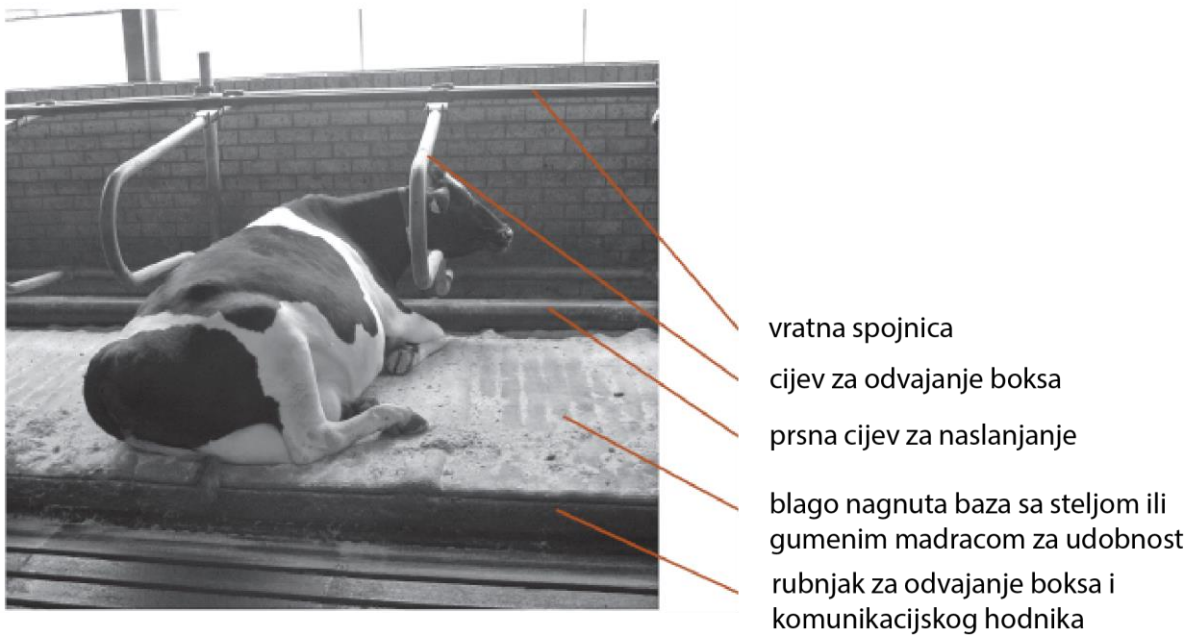
Slika 4.2.1.1 Elementi od kojih se sastoji boks (eng. cubicle ), Izvor: (Zappavigna i sur., 2017) https://www.cigr.org/sites/default/files/documets/Design_of_dairy_cow_and_replacement_heifer_housing-CIGR_working_group_Cattle_housing-2015.pdf
