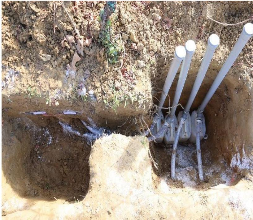
**Slika 3.2.4.**Spajanje armiranih fleksibilnih cijevi sa spremnikom
