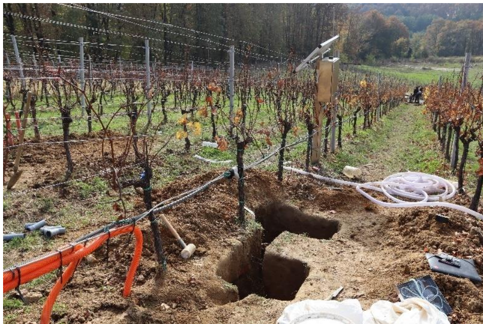
Slika 3.2.1. Iskop rupe za postavljanje tlačnih lizimetara
