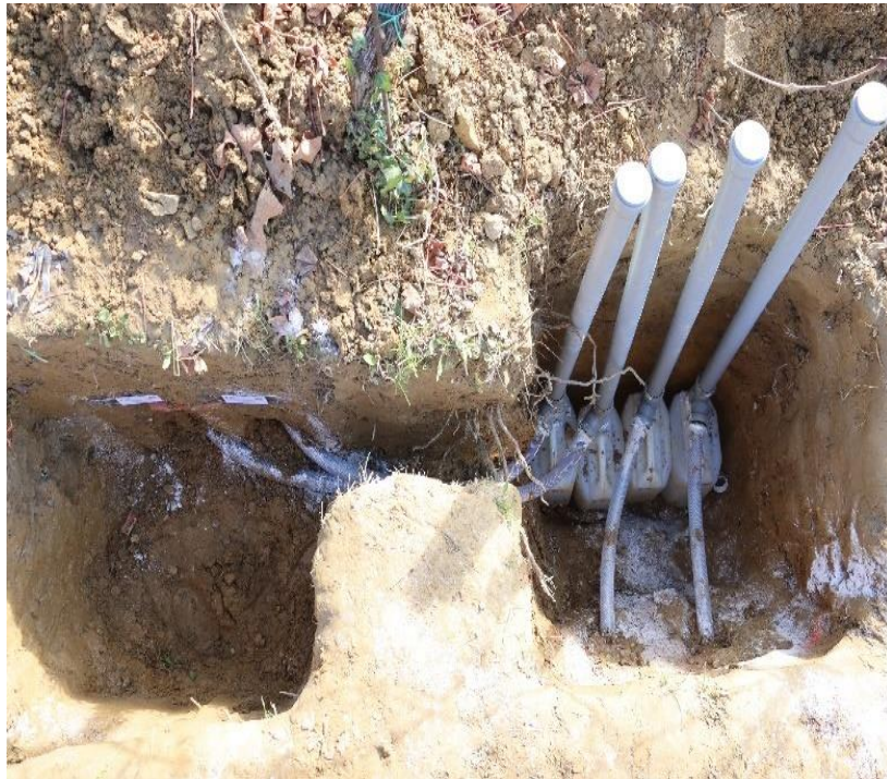
Slika 3.2.4. Spajanje armiranih fleksibilnih cijevi sa spremnikom
