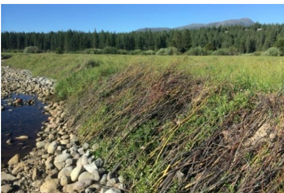
Slike 4.7 i 4.8: Ublažavanje erozije korita i obala postavljanjem madraca od grana (Izvori: https://www.wildscape-engineering.com/ , https://www.salixrw.com/ – pristupljeno 15.2.2021.)
