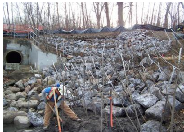
Slike 4.11 i 4.12: Ublažavanje erozije korita i obala postavljanjem vegetacijskog riprap-a (Izvori: https://www.mwcd.org/ , https://www.terraerosion.com/ – pristupljeno 15.2.2021.)
