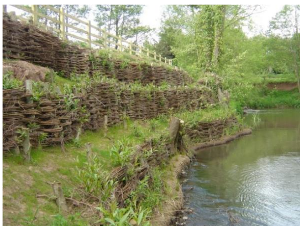
Slike 4.3 i 4.4: Ublažavanje erozije korita i obala korištenjem metode tkanja s vrbama (Izvori: https://www.salixrw.com/ , https://grassandflower.co.uk/ – pristupljeno 15.2.2021.)
