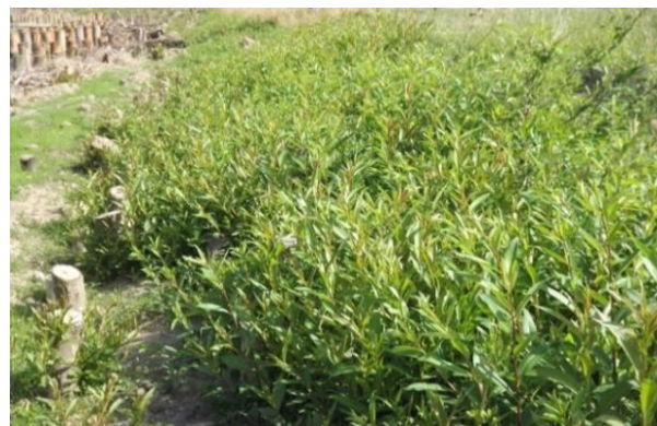
Slike 4.7 i 4.8: Ublažavanje erozije korita i obala postavljanjem madraca od grana (Izvori: https://www.wildscape-engineering.com/ , https://www.salixw.com/ – pristupljeno 15.2.2021.)
