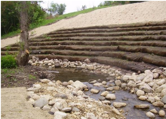
Slike 4.5 i 4.6: Ublažavanje erozije korita i obala postavljanjem vegetacijske geomreže (Izvori: https://megamanual.geosyntec.com/ , http://www.goldenvalleymn.gov/ — pristupljeno 15.2.2021.)
