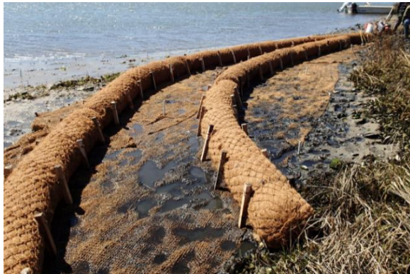
Slike 4.9 i 4.10: Ublažavanje erozije korita i obala postavljanjem valjaka od kosovih vlakana (Izvori: https://www.delawarelivingshorelines.org/ , https://www.salixrw.com/ – pristupljeno 15.2.2021.)
