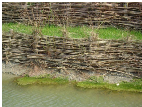
Slike 4.3 i 4.4: Ublažavanje erozije korita i obala korištenjem metode tkanja s vrbama (Izvori: https://www.salixrw.com/ , https://grassandflower.co.uk/ – pristupljeno 15.2.2021.)
