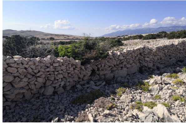
Slika 152. i 153. Suhozid na ulazu ojačan betonskim stupovima i sukcesija kao jedan od glavnih uzročnika urušavanja suhozida
