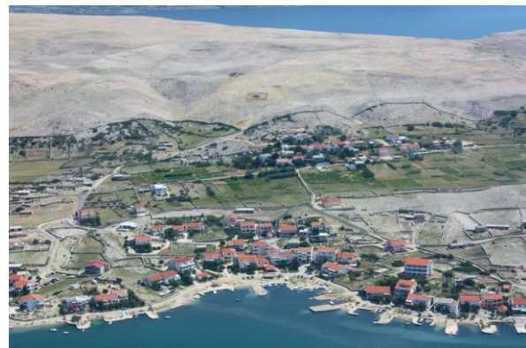
Slika 176. Noviji dio naselja Kustići smješten uz more na najnižem dijelu SZ sporednog hrbata
