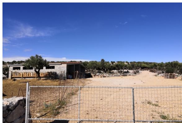
Slika 53. Novopodignuta gospodarska građevina
