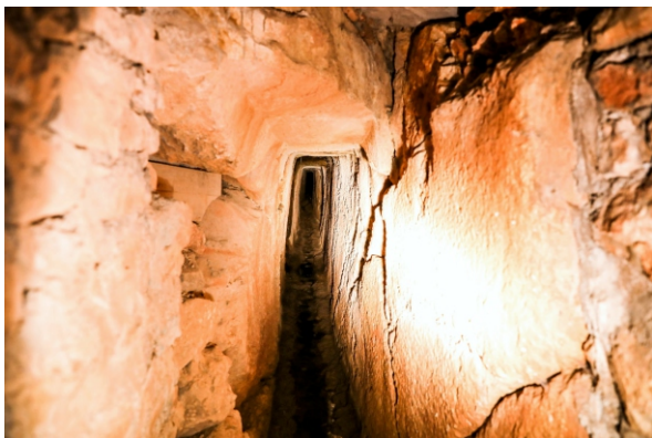
Slika 101. Antički vodovod probijen kroz živu stijenu sa vidljivom kinetom
