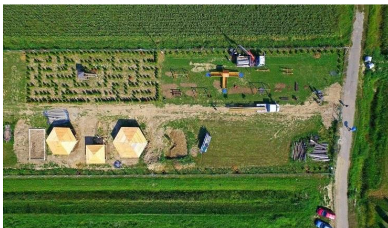
Slika 26. Snimka iz zraka na RES Antunovac tijekom izgradnje
