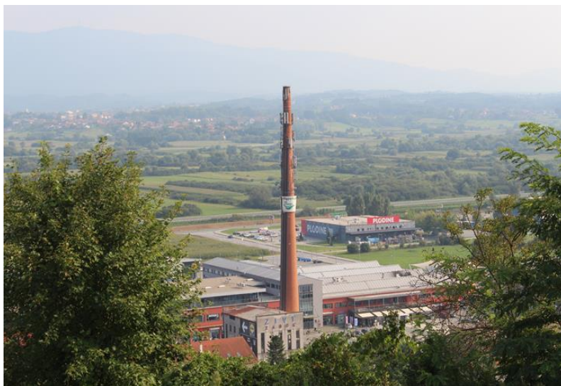
Slika 22_Dimnjak tvornice ZIVT
