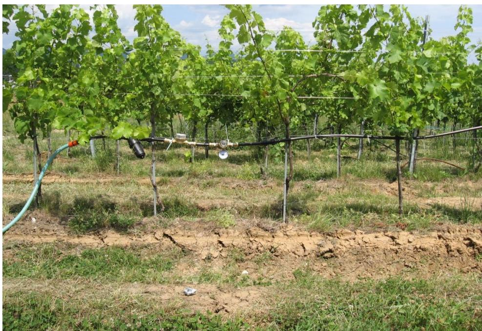
Slika 3. Dijelovi sustava kapanja; filter, regulator tlaka sa manometrom, vodomjer i lateralni
