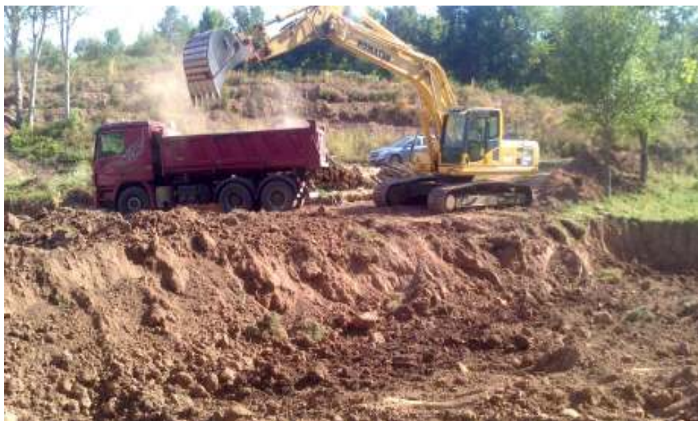
Slika 2 Izrada akumulacije (foto: N.W. Brkić)
