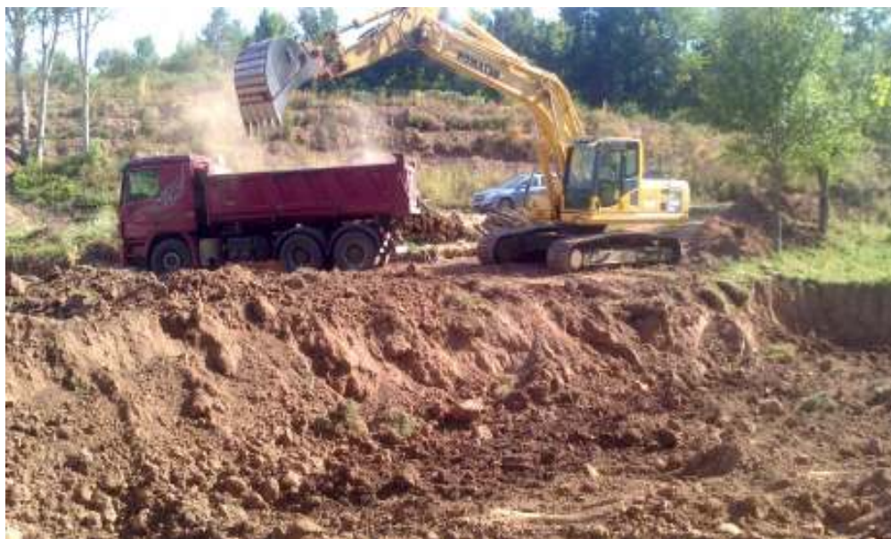
Slika 2 Izrada akumulacije (foto: N.W. Brkić)
