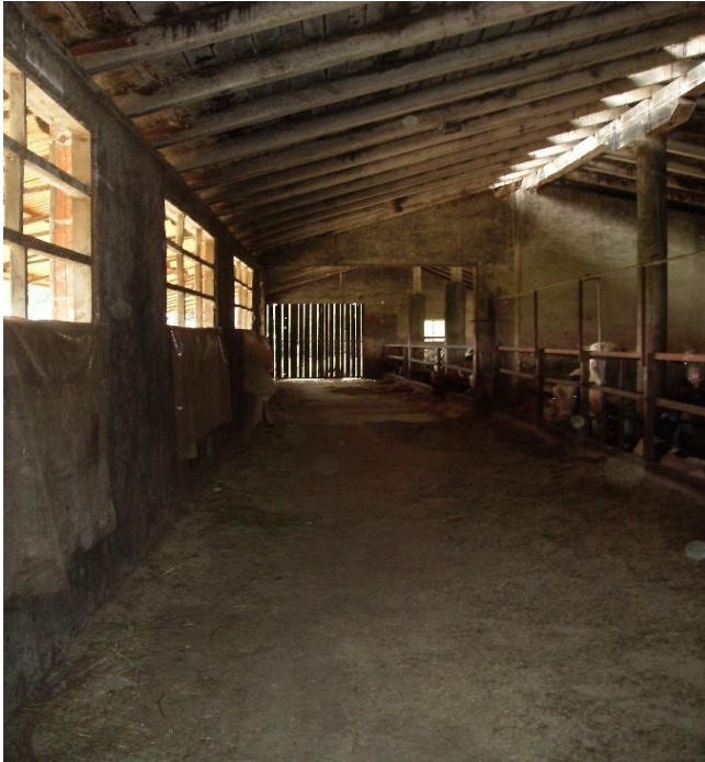
Slika 7. Dio stajskog objekta, hranidbeni hodnik.
