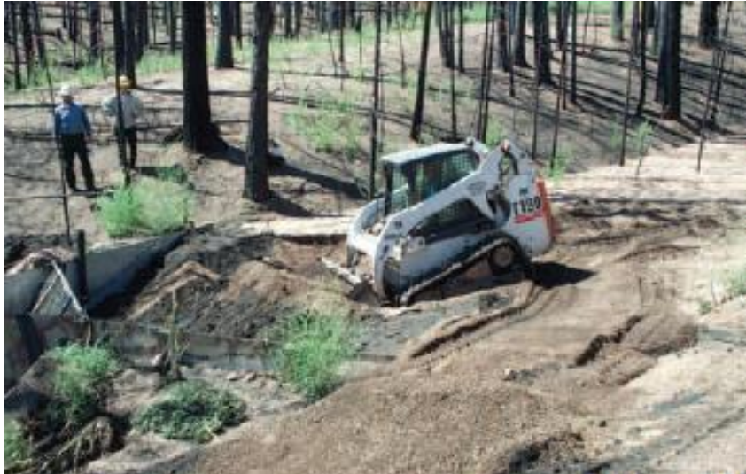
Slika 23. Postavljanje ograde od mulja
