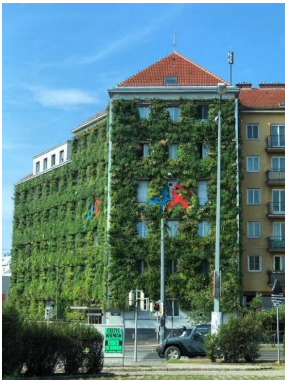
Slika 4. Zeleno pročelje, stambena zgrada, Beč, 2019. Izvor: Osobna arhiva, fotografija: Nikolina Maslač
