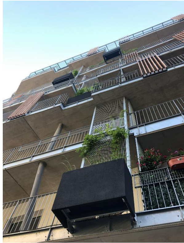
Slika 3. Sustav rešetke s penjačicom, Seestadt, Beč, 2019. Izvor: Osobna arhiva, fotografija: Nikolina Maslač
