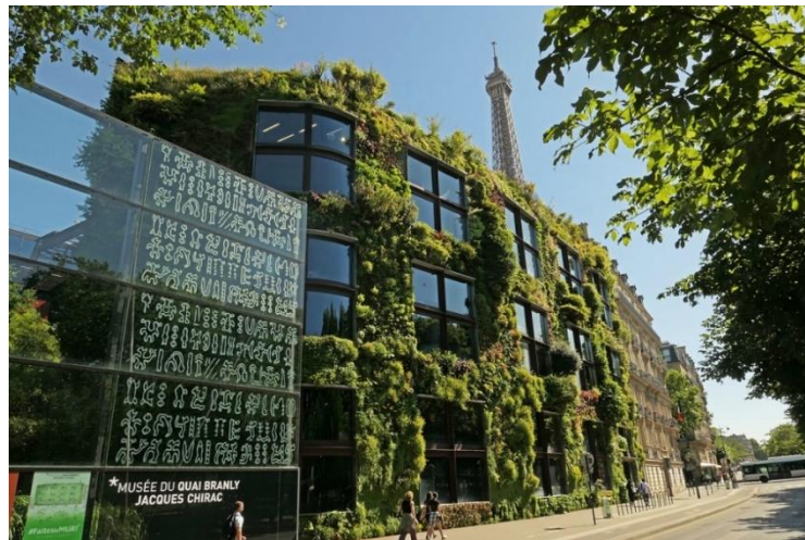
Slika 2. Primjer građevine s vertikalnim vrtom u Parizu ( https://www.ekovjesnik.hr )
