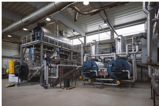
Slika 2.10. Preradbeni dio (sterilizatori, sušara) Izvor: Agroteinika d.d.
