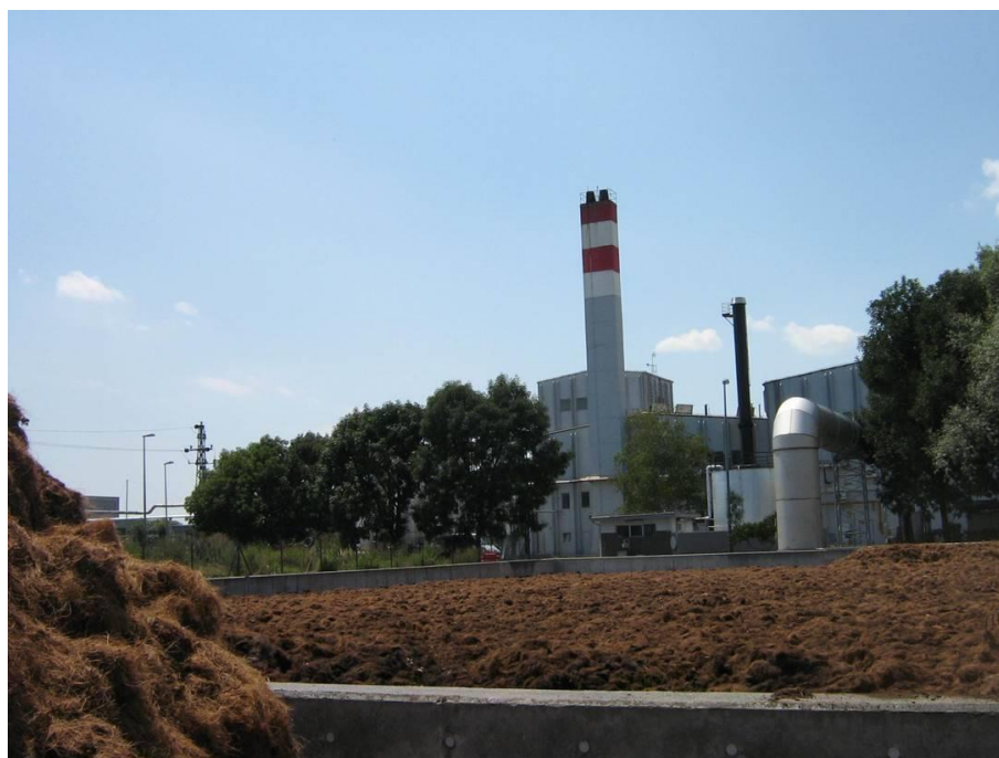
Slika 2.12. Biološki pročišćivač zraka (kokosova vlakna)
