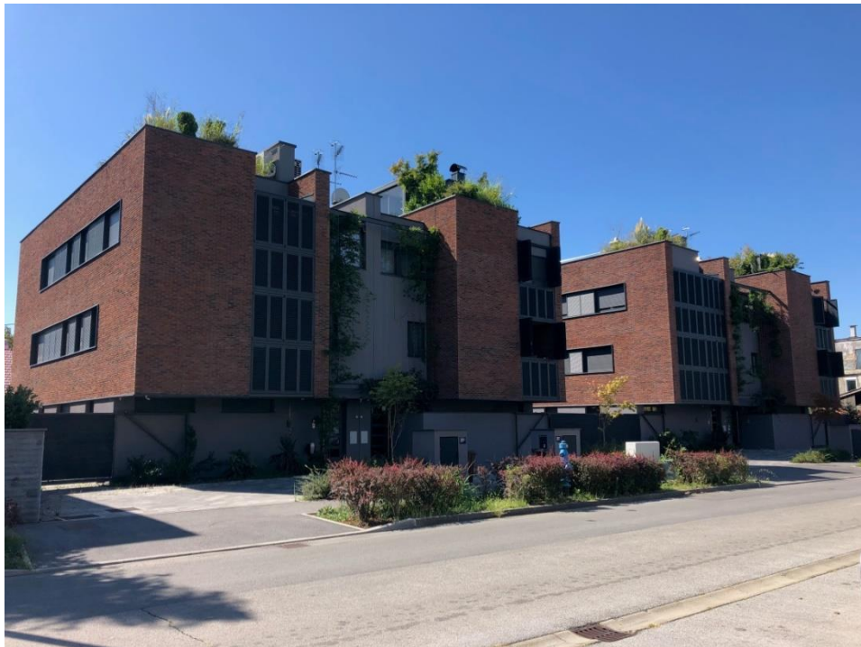
Slika 8. Zeleni zid i krov, zelena zgrada Hrgovići, Jarun, Zagreb Izvor: Osobna arhiva, fotografija: Matea Korasić
