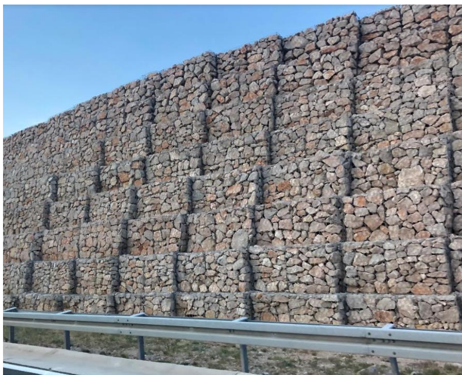
Slika 35. Gabionski zid izveden uz Autocestu A1 Izvor: Osobna arhiva, fotografija: Matea Korasić
