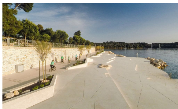
Slika 18. Plaža Mulini_prikaz betonskog dijela plaže (Izvor: https://vizkultura.hr/plaza-mulini/ )
