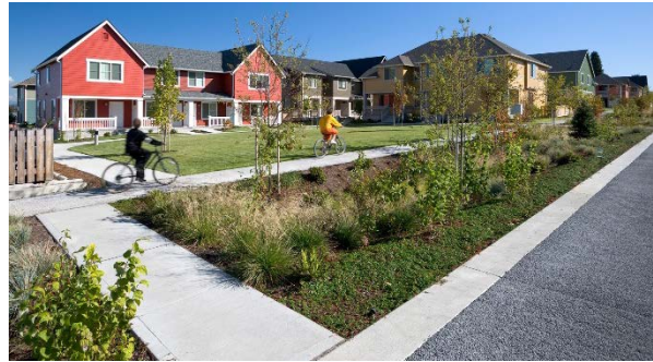
Slika 9. i slika 10. Prikaz bioswalea u naselju High Point (Izvor: http://mithun.com/project/high-point/ )
