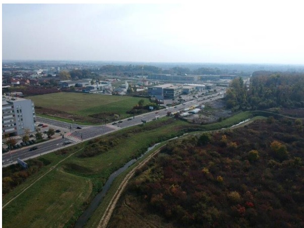
Slika 8. Pogled na južni dio potoka.
