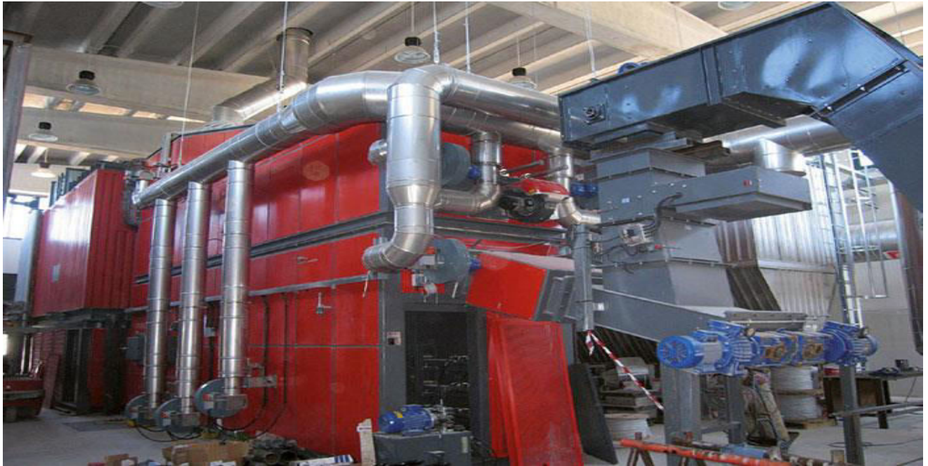
Slika 8. Unutrašnjost pogona elektrane Fuisis (Izvor: http://fuisis.com/ )
