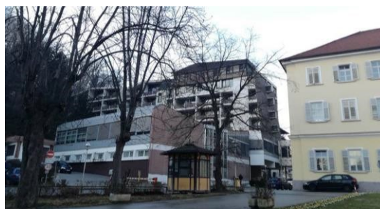
Slika 3.5. Južno pročelje Specijalne bolnice Krapinske Toplice
