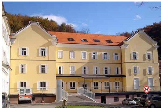
Slika 3.6. Zgrada Specijalne bolnice Akromion
