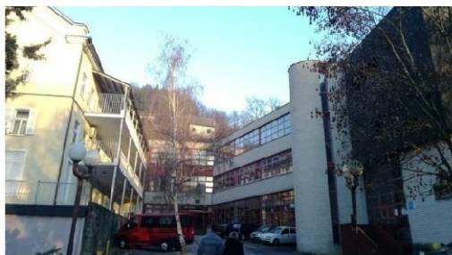
Slika 3.8. Zgrada Centra za odgoj i obrazovanje
