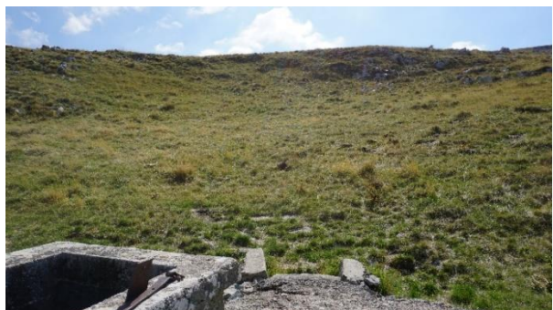
Slika 361. i 362. Gusterna za skupljanje oborinske/slivne vode izgrađena uz brdašce s kojeg se slijeva voda
