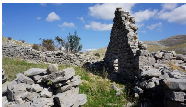
Slika 326. i 327. Pritorak uz gornji kat košare za ovce iz kojeg ovce mogu ući u košaru
