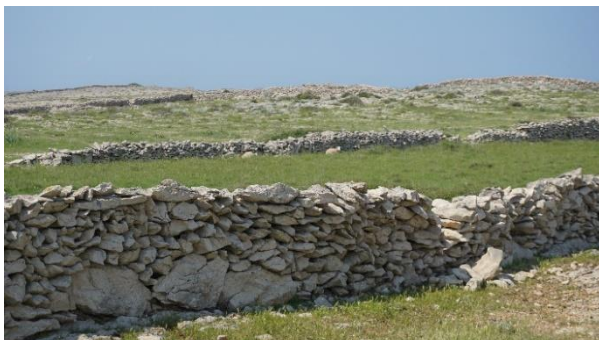
Slika 117. i 118. Neodržavani jednostruki suhozid na njivi koja je prenamijenjena u pašnjak
