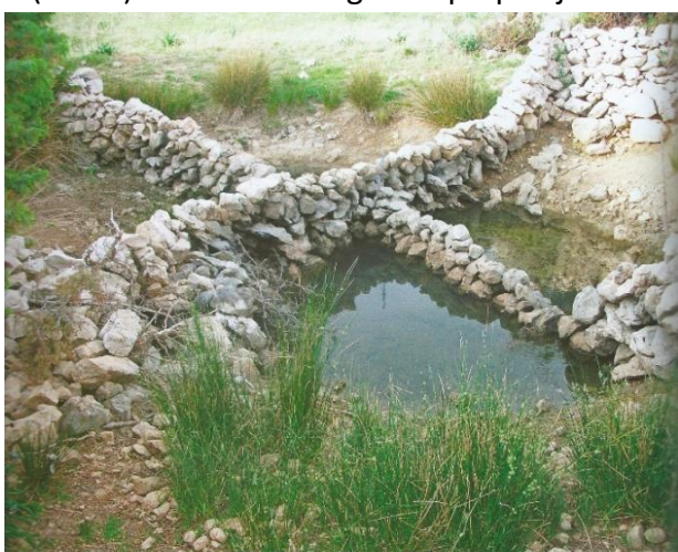
Slika 209. i 210. Lokve pregrađene suhozidom na četiri i dva dijela vjerojatno radi dijeljenja vlasništva (Izvor: Oštarić, I. (2017.) Stani otoka Paga: Od prapovijesti do danas, str. 282 i 569)
