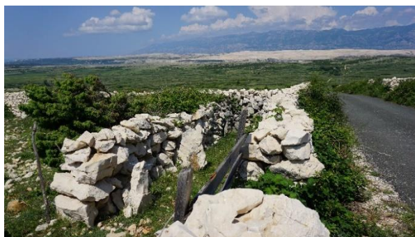
Slika 168. i 169. Tor na području Mandre. Obzirom na uzak put koji je između parcela pašnjaka, ulazni prostor je izmaknut unutar parcele kako bi se osigurao dodatni predprostor vjerojatno za prikupljanje ovaca, donošenje tereta, a danas i za vozila. Drugi tor na ulasku u pašnjak paralelan s vanjskim suhozidom na području Kolana
