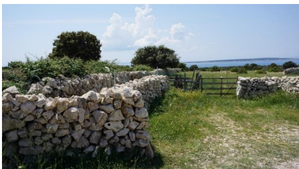
Slika 168. i 169. Tor na području Mandre. Obzirom na uzak put koji je između parcela pašnjaka, ulazni prostor je izmaknut unutar parcele kako bi se osigurao dodatni predprostor vjerojatno za prikupljanje ovaca, donošenje tereta, a danas i za vozila. Drugi tor na ulasku u pašnjak paralelan s vanjskim suhozidom na području Kolana
