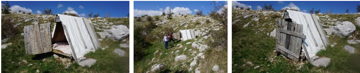
Slika 319., 320., 321. Kolibica za dvoje novije gradnje koja nije nalik na onakve kakve su se gradile u prošlosti od ševara
