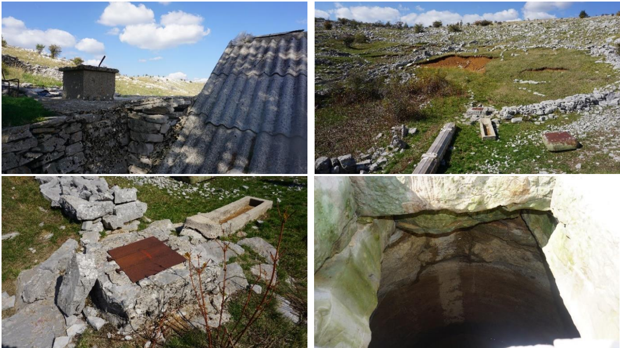
Slika 357., 358., 359., 360. Bunar ili gusterna iznad košare koja se i danas koristi te betonski bunar s kamenim pokrovom s kamenim koritom za pojenje stoke
