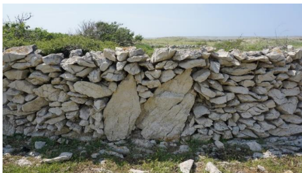
Slika 116. Jednostruki suhozid s velikim stijenama u podnožju koji ograđuje nekadašnju njivu, a sada pašnjak u katastarskoj općini Poveljana
