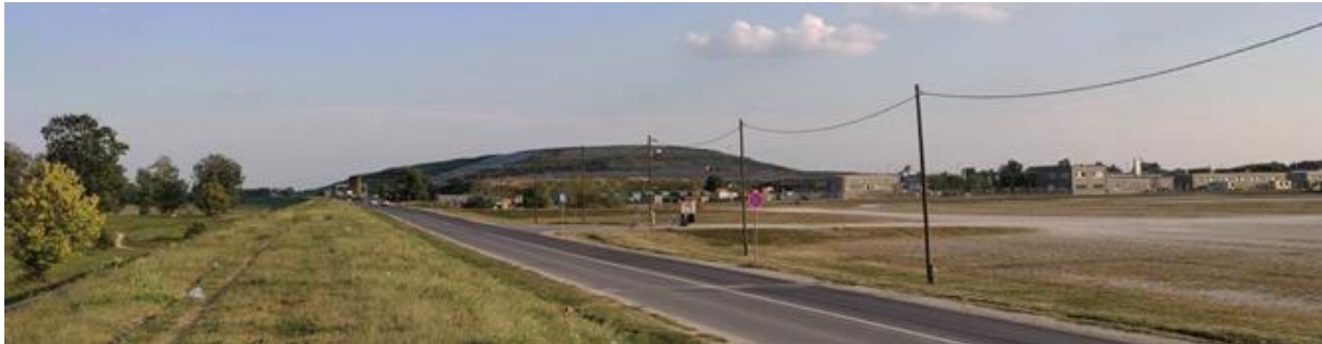
Slika 81: Pogled s točke E-1 na Jakuševac
