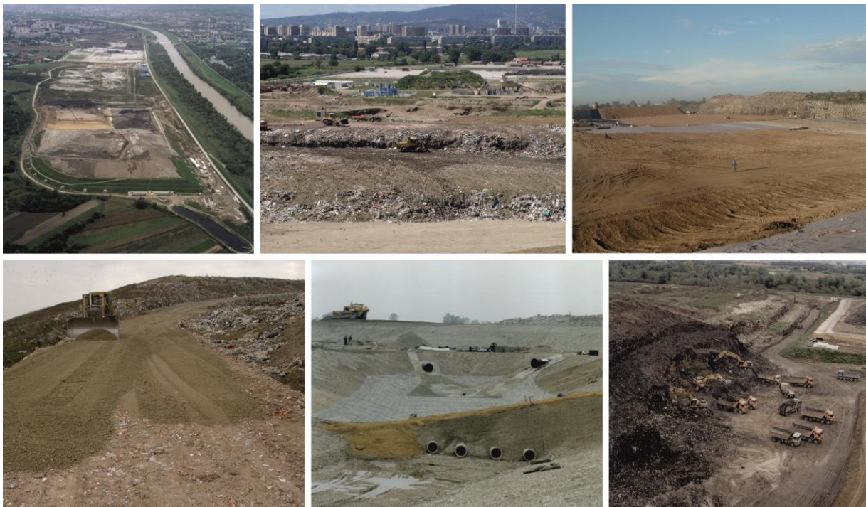
Slika 62: Fotografije (a., b., c., d., e., f.) tijekom sanacije ( http://gin.hr/hr/ )
