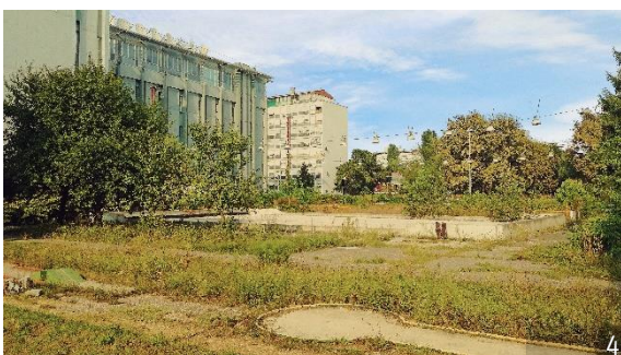
SLIKA 24: Pogled na derutne sportske površine (2018.)
