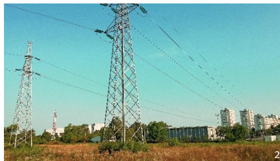
SLIKA 32: Pogled na dalekovod i trafostanicu (2018.)
