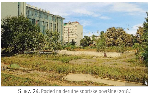
SLIKA 24: Pogled na derutne sportske površine (2018.)
