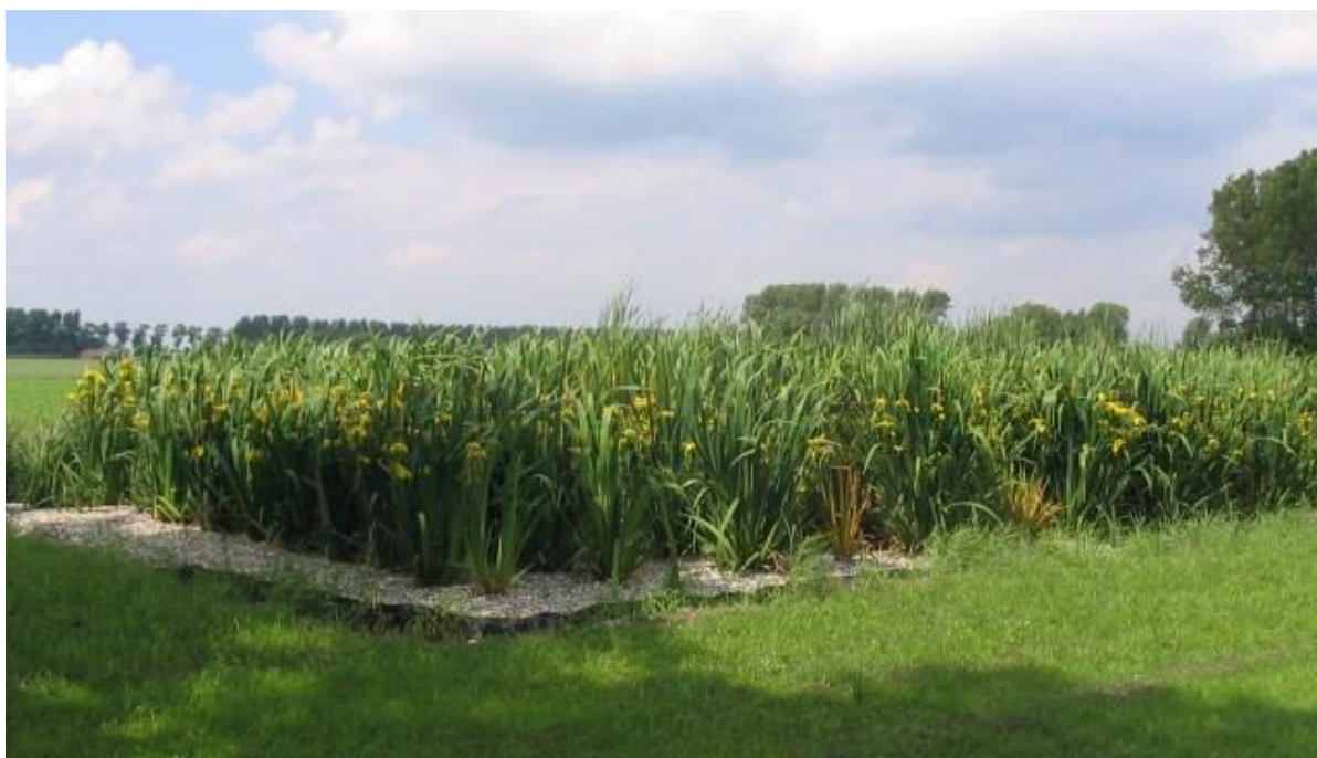
Slika 13. Biljni uređaj za pročišćavanje voda Izvor: http://www.kilianwater.nl
