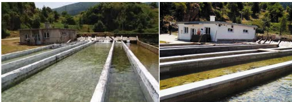
Slika 3.3.1.1. i 3.3.1.2. Ribogojilište Pećina (Kostelka) u Lešću prije i nakon obnove
