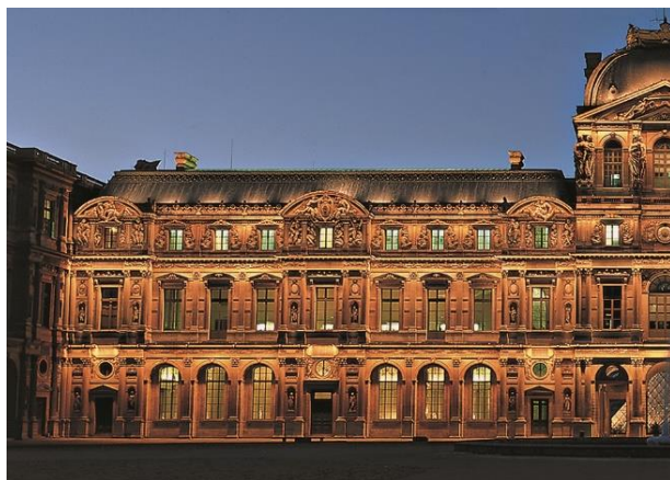
Slika br. 3 Pročelje palače piramida
