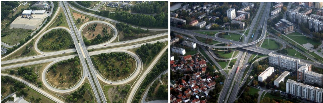
Slika 1.4. Usporedne fotografije pravilnog raskrižja „list djeteline“ Maduravoyal na Nacionalnoj Indijskoj autocesti i petlje Držićeve-Slavonska
