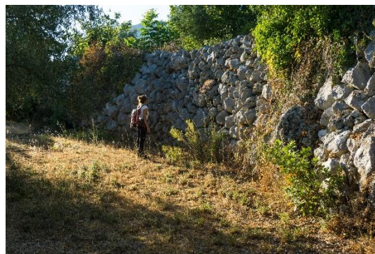
Sl.7.25.4. Visoki podzid terase
