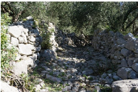
Sl.7.26.7. Kamenom opločana i suhozidom omeđena staza kroz maslinike
