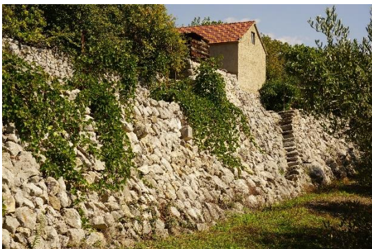
Sl.7.16.3. Visoka „škalka“ s interpoliranim stepenicama
