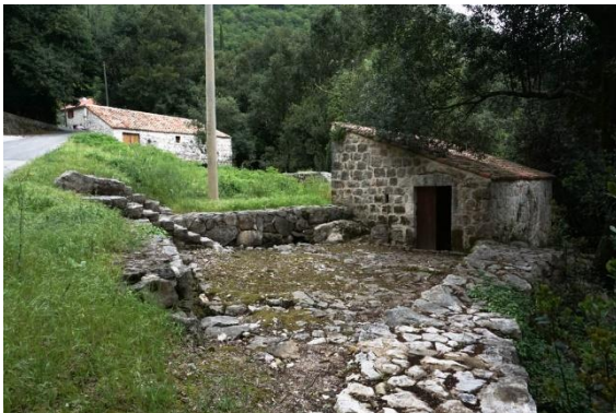
Sl.7.19.7. Podzid uz mlinicu i kamenom opločani pod
