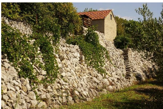
Sl.7.16.3. Visoka „škalka“ s interpoliranim stepenicama
