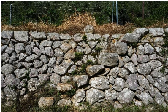
Sl.7.22.5. Interpolirane stepenice u podzidu
