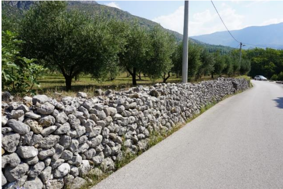
Sl.7.19.5. Podzid uz cestu
