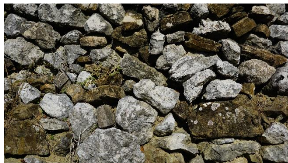
Sl.7.18.3. i 7.18.4. Podzidi voćnjaka građeni kamenjem različitog sastava (vapnenac, fliš), te kanal građeni u suho
