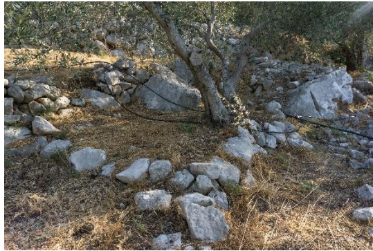
Sl.7.25.6. Manja terasa podzidana jednim redom kamenja
