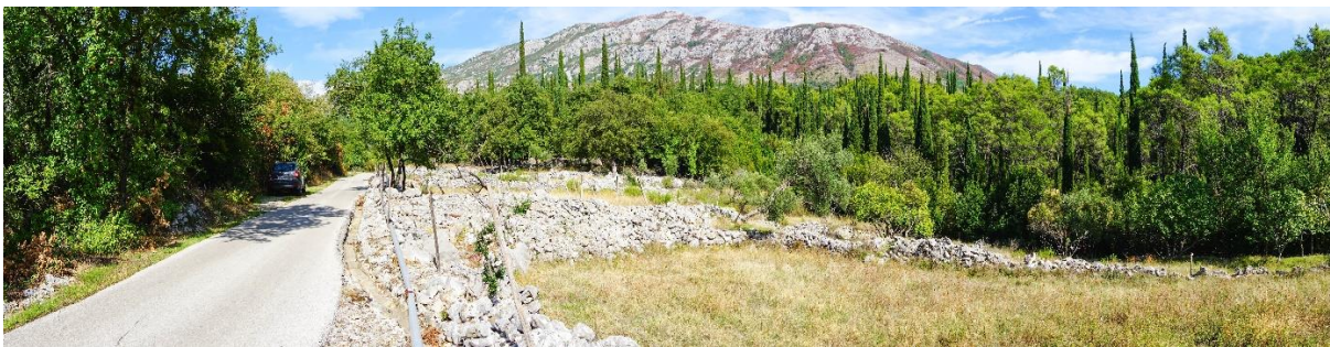
Sl.7.24.7. Obnovljene terase uz cestu
