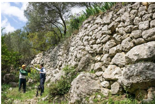
Sl.7.18.5. Visoki podzid Pijeve ulice, 4,1 m
