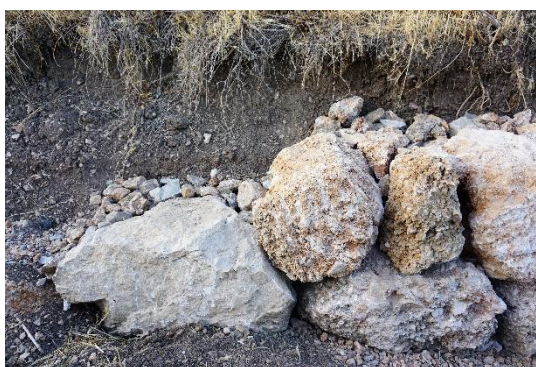
Sl.7.14.4. Početak podzidavanja – kamen vapnanac i breča
