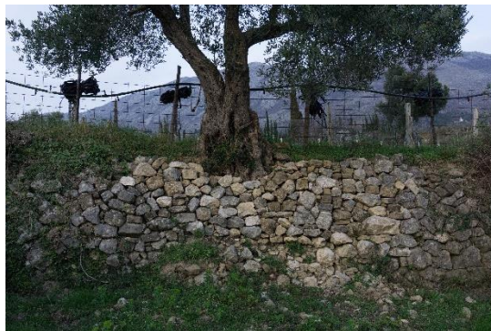
Sl.7.21.4. Obnovljeni podzid u masliniku
