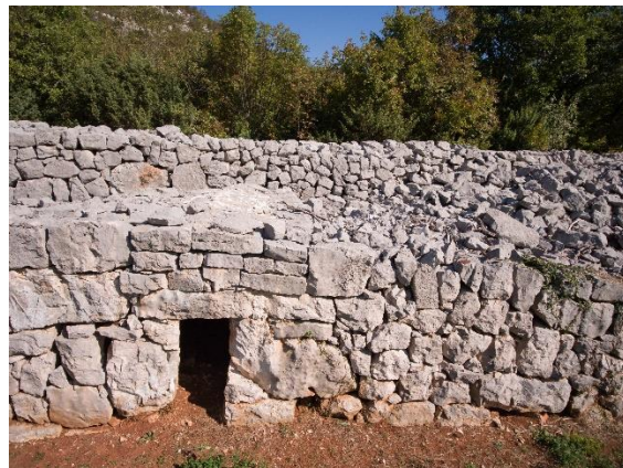
Sl.7.31.4. Sklonište i spremište za alat interpolirano u gomili/međi
