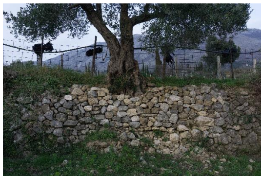
Sl.7.21.4. Obnovljeni podzid u masliniku
