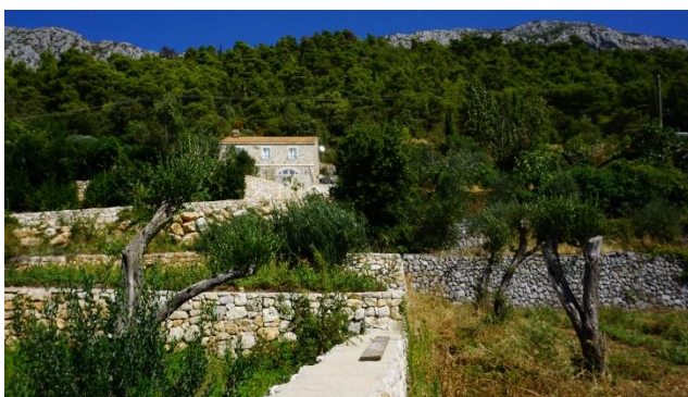
Sl.7.18.8. Susret suhozida i betonskog zida
