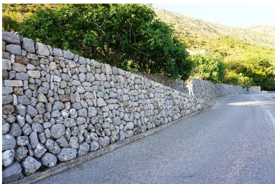
Sl.7.14.3. Podzid uz glavnu prometnicu
