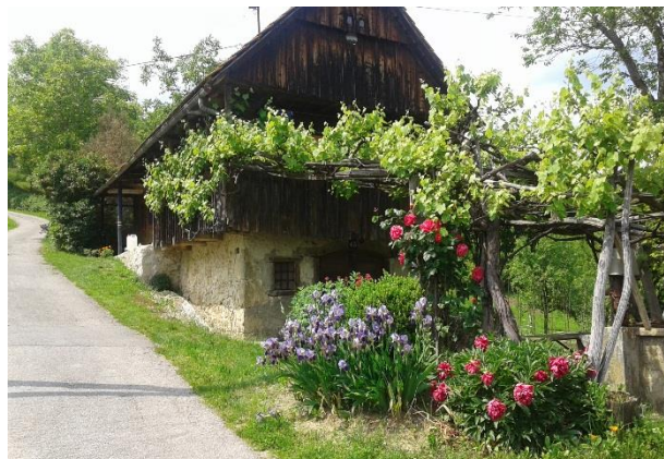
Slika 12.: Kuća u Donjem Oštrcu (foto: Relić, 2016.)
