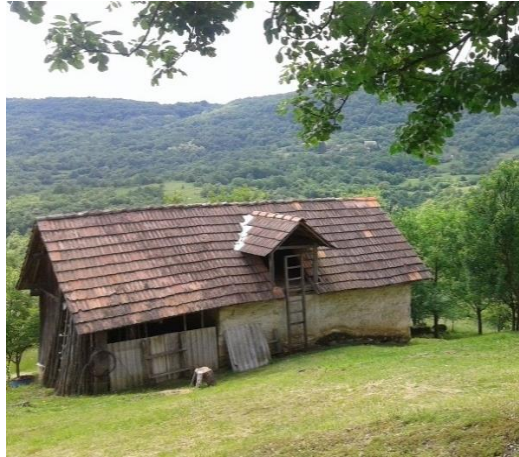
Slika 10. Oštrc, gospodarska zgrada (foto: Relić, 2016.)
