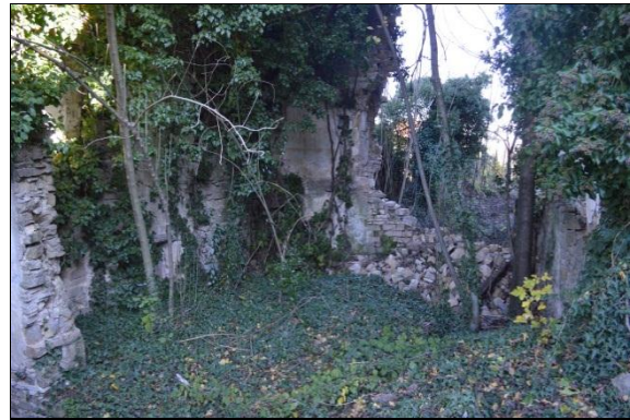
Sl. 23: Ruševna zgrada u zapuštenom području
