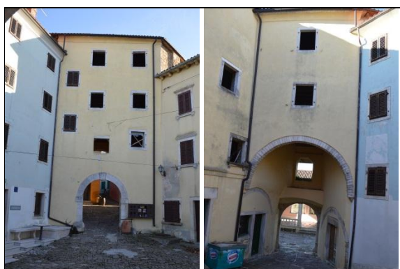
Sl. 45: Ulazna kula s vanjske i unutarnje strane
