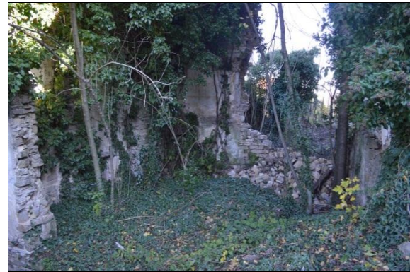
Sl. 23: Ruševna zgrada u zapuštenom području
