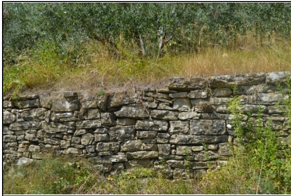
Sl. 67: Potporni zid
