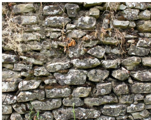
Slika 3.54. Većinom zaobljeni kameni blokovi slagani u pravilne redove (sjever obuhvata)
