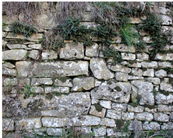
Slika 3.52. Veliki, pravilni blokovi kamena unutar zida (zapad obuhvata)
