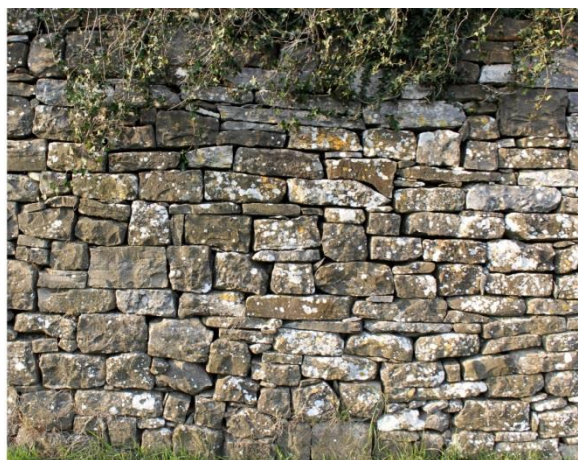
Slika 3.50. Mješavina većih i manjih pravilnih blokova kamena (istok obuhvata)
