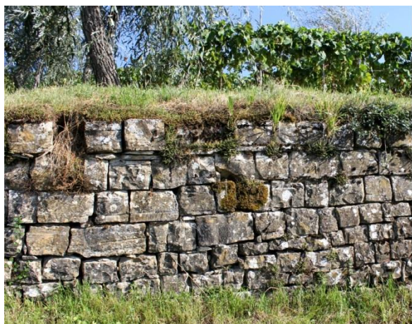
Slika 3.49. Veći, pravilni blokovi kamena slagani u pravilne redove (jugozapad obuhvata)
