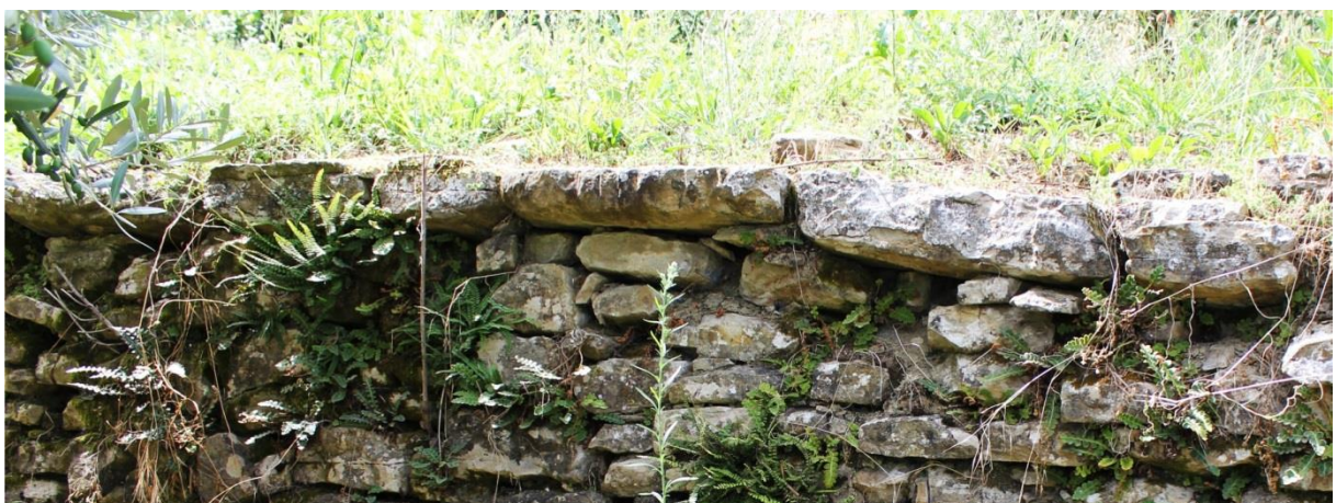
Slika 3.58. Završetak zida s većim, položenim komadima kamena
