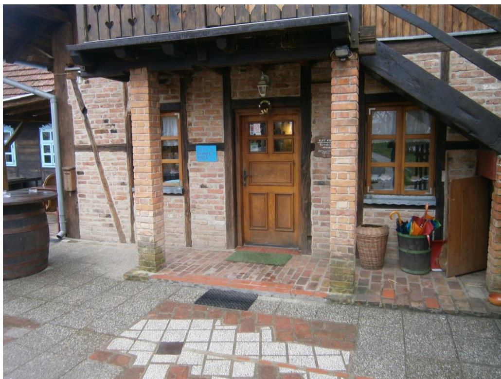
Slika 12. Glavni ulazni prostor (Foto: Silov, 2016)
