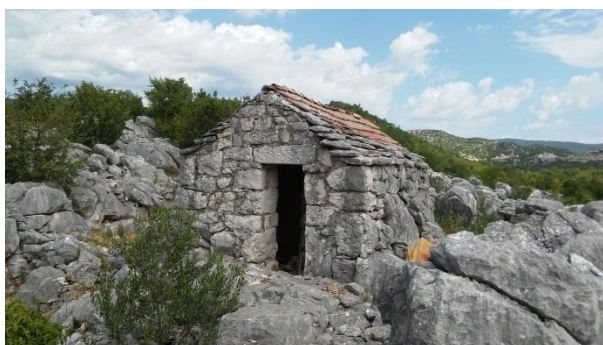
Slika 67.: Kameno skrovište u Kostanjskoj ljuti
