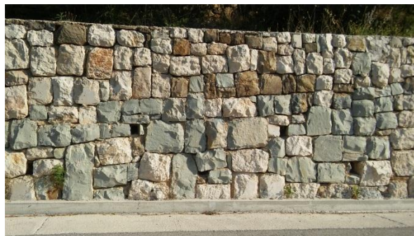
Slika 80.: Način slaganja suhozida, Podgrađe
