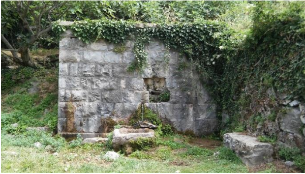
Slika 56.: Izgrađeni izvor, Kostanje
