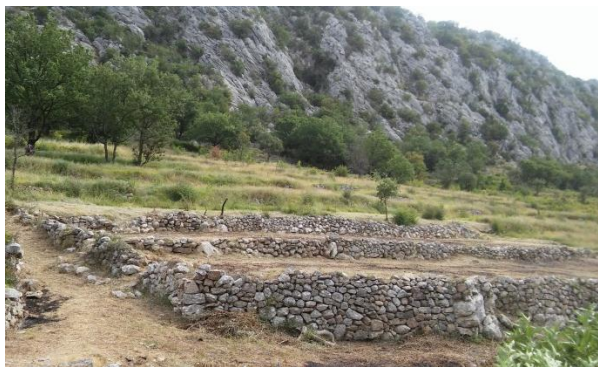
Slika 69.: Potporni suhozidi terasa, Smolonje
