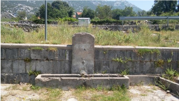
Slika 58.: Izgrađeni presušeni izvor, Ostrvica
