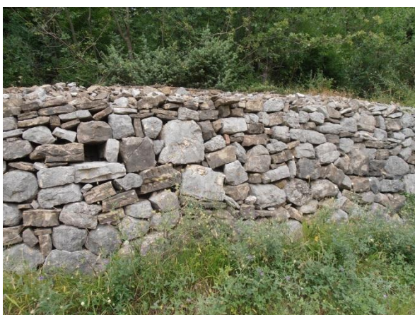
Slika 78.: Način slaganja suhozida, Čisla
