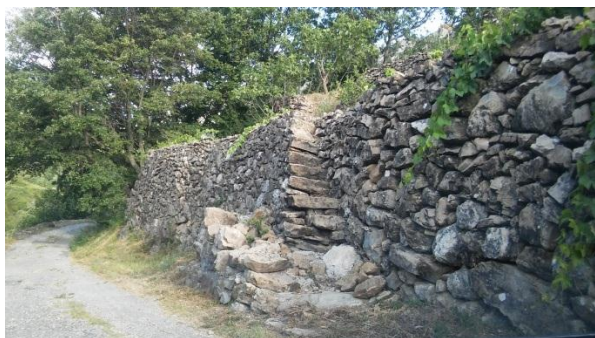
Slika 71.: Potporni suhozid uz prometnicu, Smolonje
