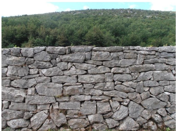
Slika 77.: Način slaganja suhozida, Gata
