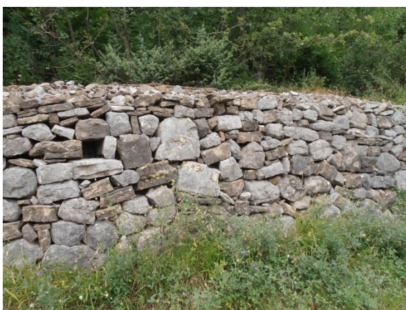
Slika 78.: Način slaganja suhozida, Čisla
