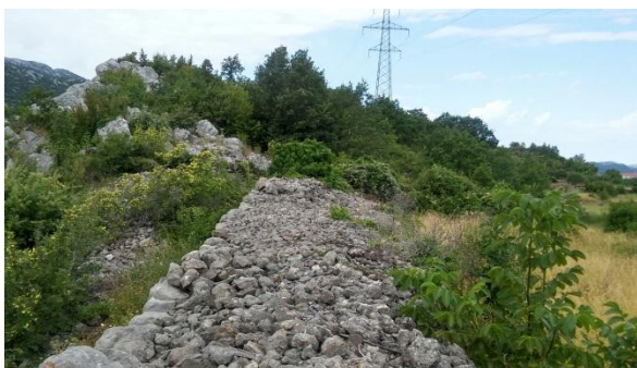
Slika 82.: Gornja obrada suhozida, Kostanje
