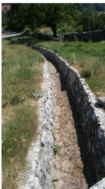
Slika 54.: Cementirani terasirani vodotok, Ostrvica
