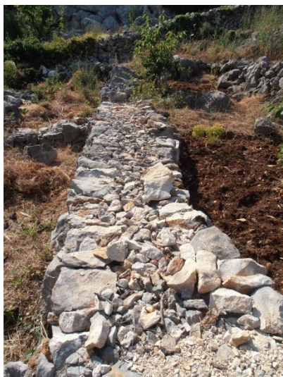
Slika 83.: Gornja obrada suhozida, Podgrađe
