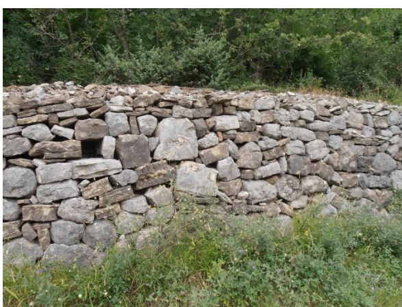
Slika 78.: Način slaganja suhozida, Čisla
