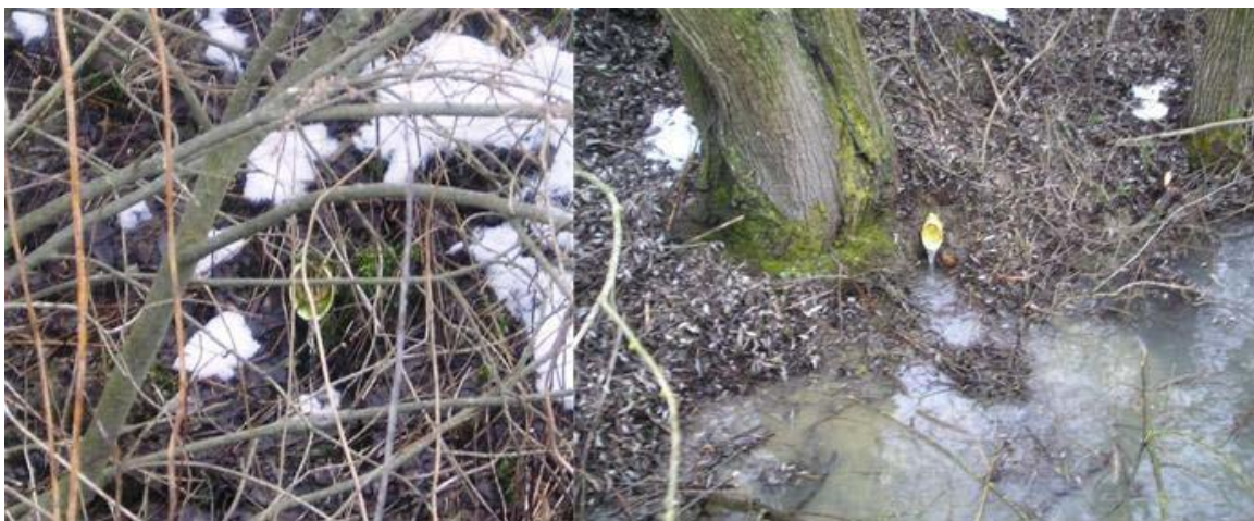
Slika 20. Prikaz lošeg održavanja hidromelioracijskih sustava detaljne odvodnje
