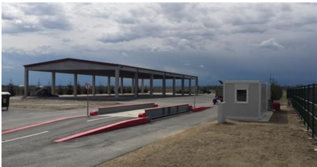
Slika 8. Prikaz kompostnog postrojenja Prelog
