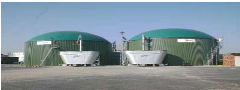
Slika 1. Dozatori i fermentori bioplinskog postrojenja
