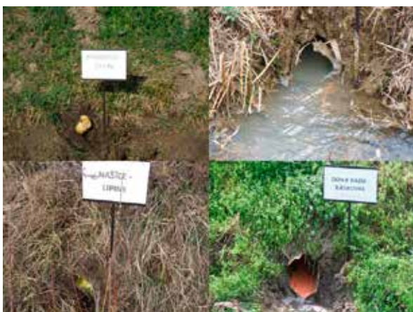
Slika 7: Fotografski prikazi kao primjeri lošeg stanja hidromelioracijskog sustava podzemne odvodnje cijevne drenaže (2017. – 2019.) (Izvor: „Drenaža zemljišta Hrvatske“, Petošić, 2021.).
