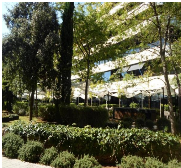
Slika 4.30. Pogled sa šetnice na jugozapadnu stranu hotela
