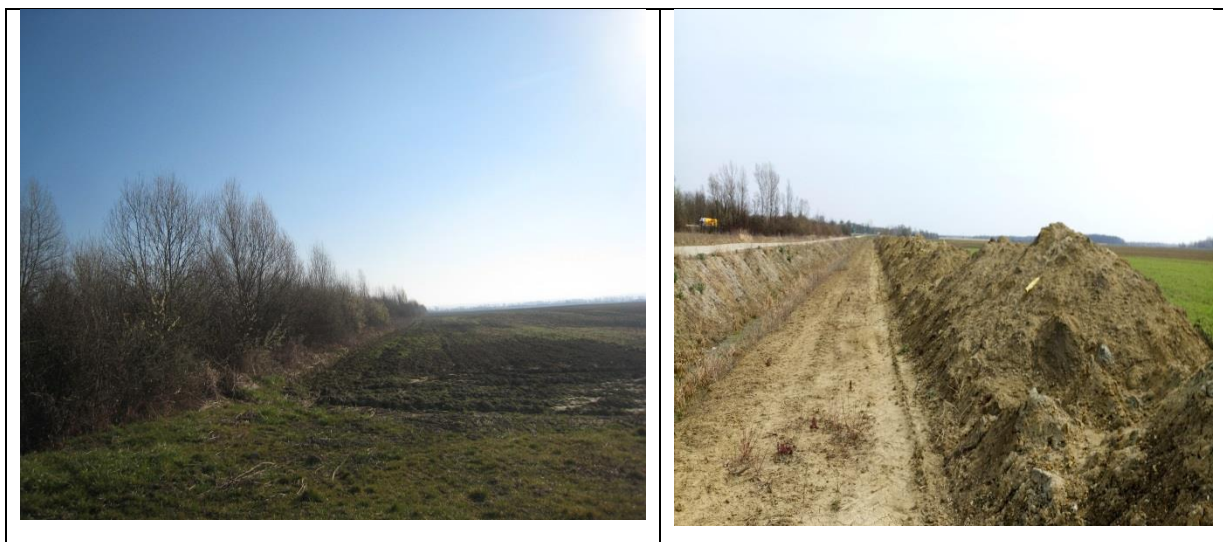
Slika 12. Neodržavana kanalska mreža na istraživanom području (lijevo) i nestručno izmuljivanje kanalske mreže sa oštećenim izljevima cijevne drenaže (desno).
