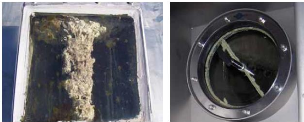
Slika 6. Elementarni sumpor, rezultat biološke desumporizacije
