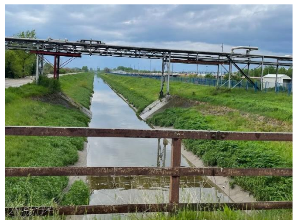
Slika 38.– Glavni odvodni kanal (J)
