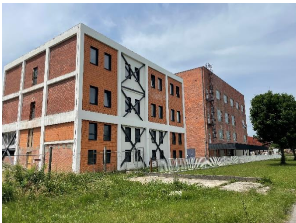
Slika 35.– Degradirana industrijska građevina (S-Z)
