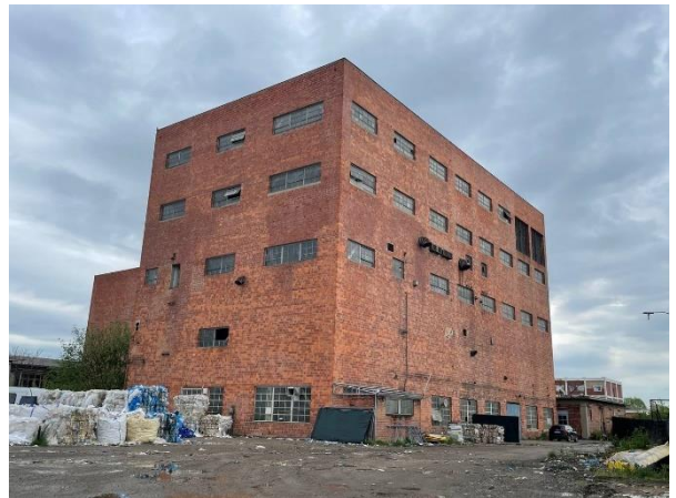
Slika 36.– Degradirana industrijska građevina (S-Z)
