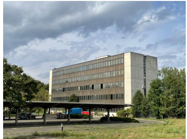
Slika 34.– Upravna zgrada „Diokija“ (S-I)
